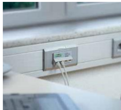
Instalación de ducto de cable
