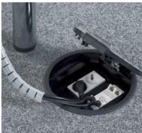
Instalación de caja de piso
